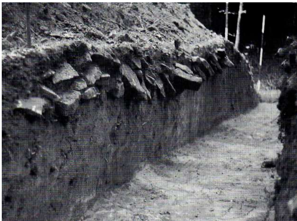
Fig. 5 : Coupe de la chaussée à Florenville (Chameleux). Détail de l'enrochement.
