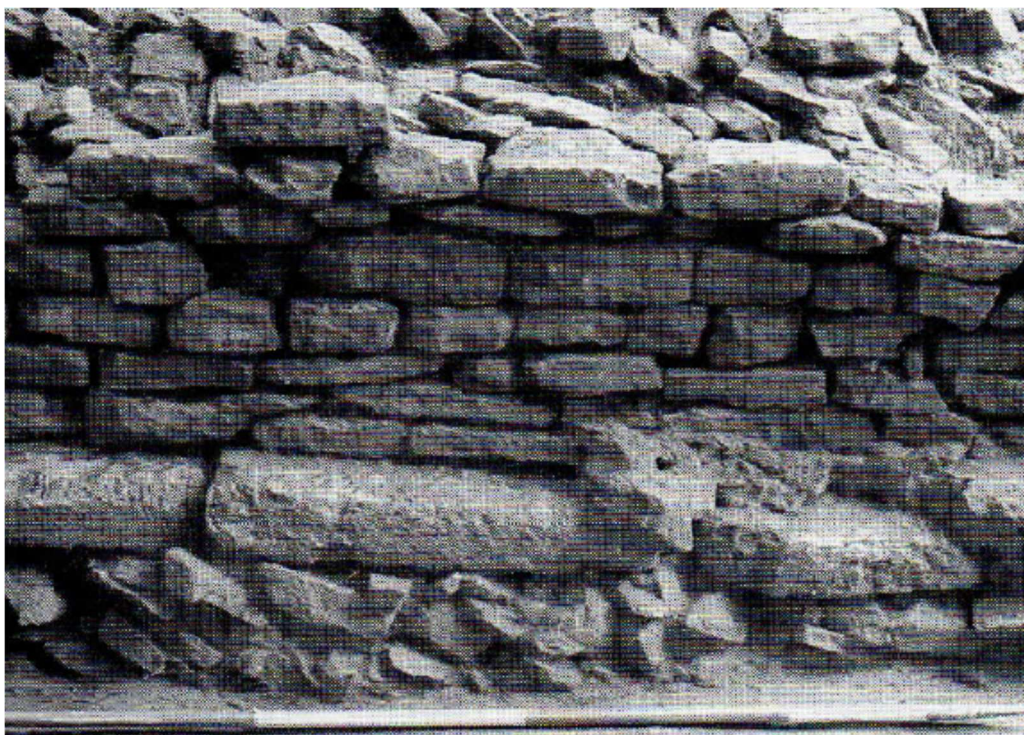
Fig. 5 : Détail de la muraille et de ses fondations comportant plusieurs rangs de moellons posés en oblique surmontés d'une assise de gros blocs taillés.
